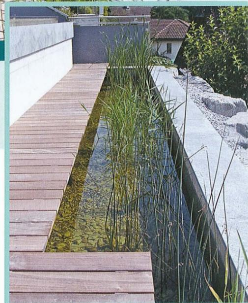
*Reinigend: Das in die Überlaufrinne fließende Wasser wird in der angeschlossenen Regenerationszone aufbereitet.*
